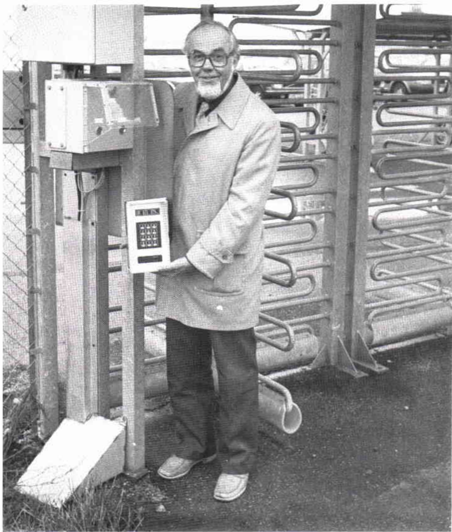
En av gånggrindarna till FFV-området i Arboga har fått ett tekniskt system för passerkontroll med kortläsare. Artikelförfattaren visar hur detta arrangerats.
